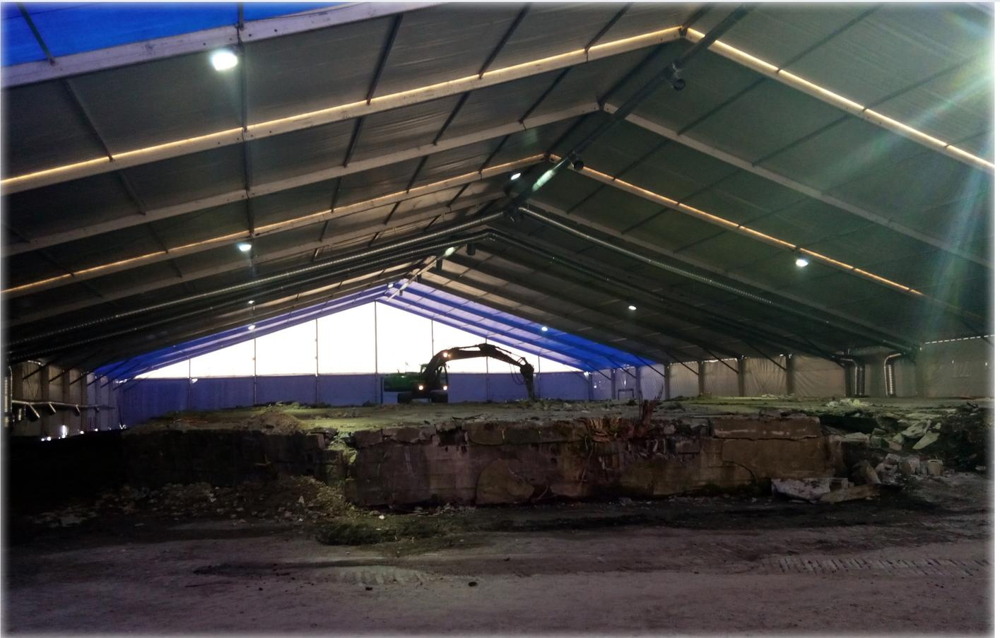
pagnée d'un traitement par filtration sur charbon actif avant rejet à l'atmosphère. En parallèle, les eaux de nappe en fond de fouille étaient pompées et traitées. Au total, plus de 26 000 m<sup>3</sup> de matériaux ont été excavés et triés avant évacuation en centres de traitement adaptés. Plus de la moitié ont été traités sur notre centre Bionor de traitement biologique situé dans le Nord de la France (département 62), le reste ayant été évacué en filières de stockage.
