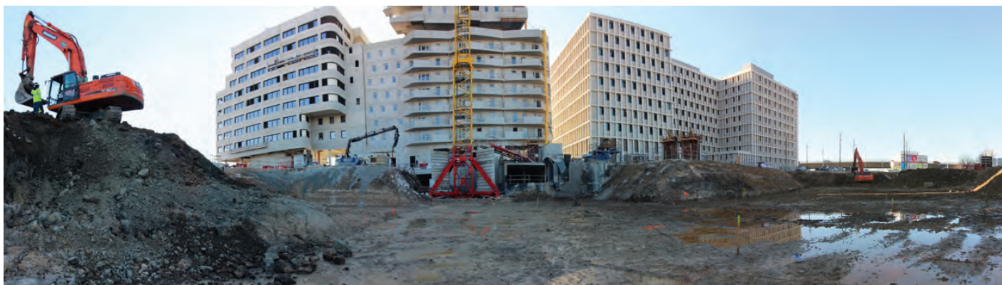
Zones de terrassement
