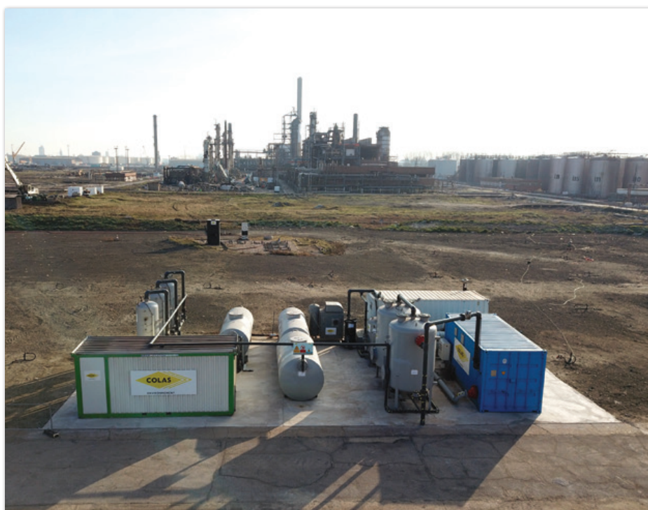
Photographie aérienne de l'installation finalisée pour la seconde série d'essais (longue durée)
