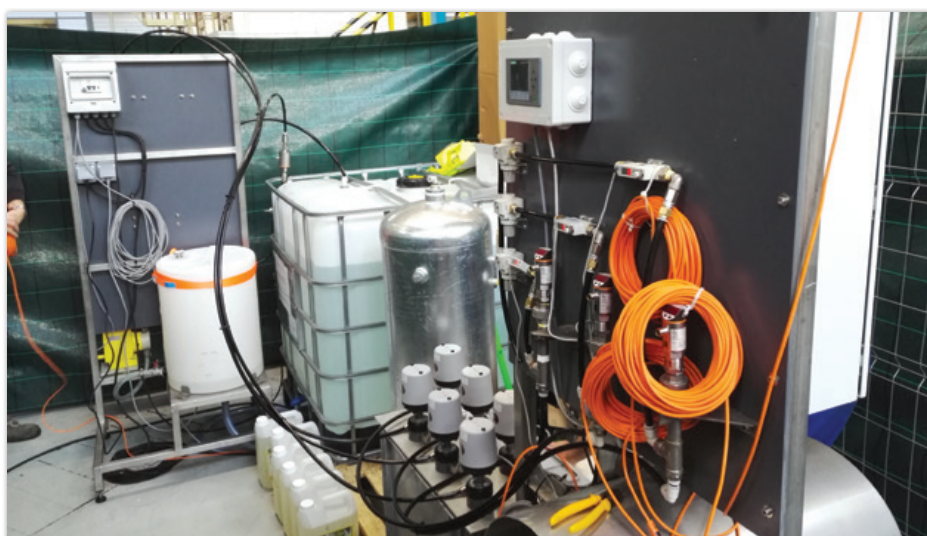
Unité d'injection de mousse de blocage.
