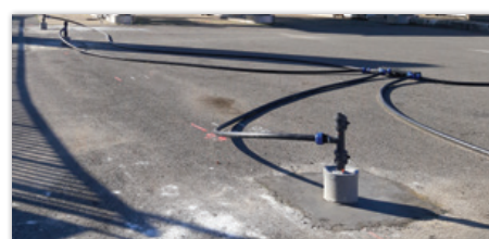
Puits et réseaux d'extraction des gaz
