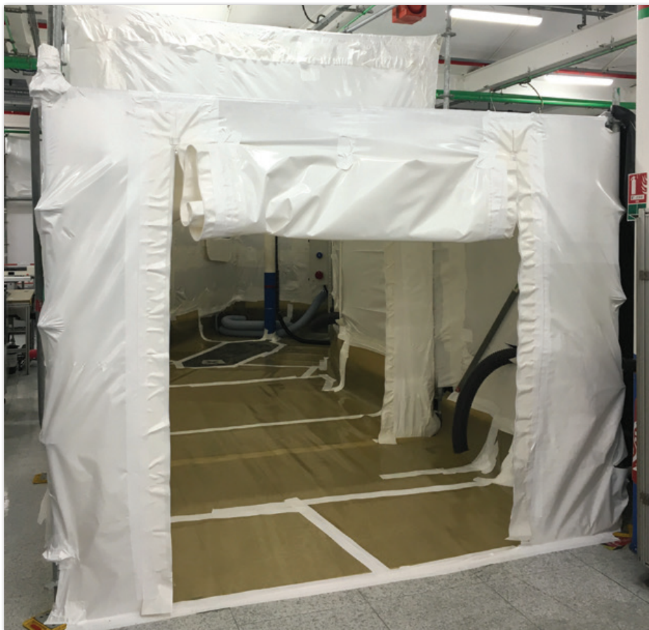
Vue d'une des trois zones de confinement
