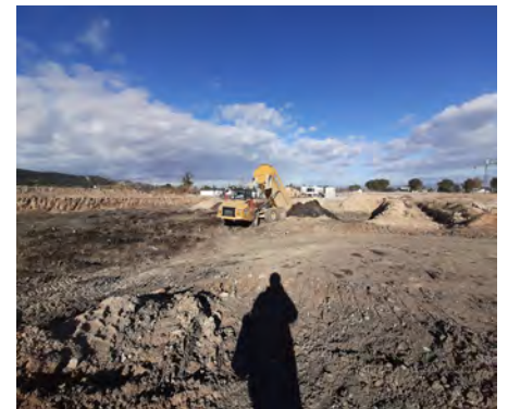
Figure 7 : suivi et tri en phase déblais / remblais
