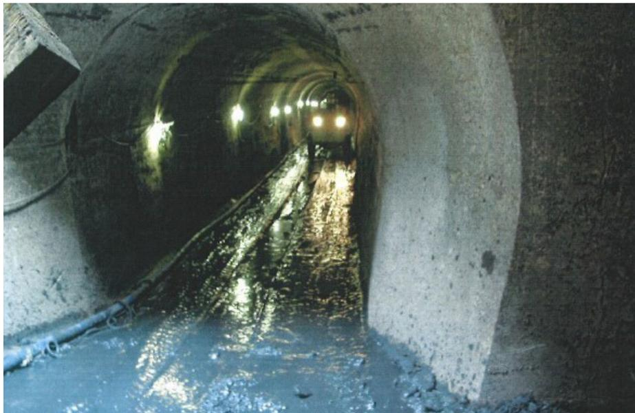
Photo 4 : Eclairage dans l'ouvrage et curage des sédiments
