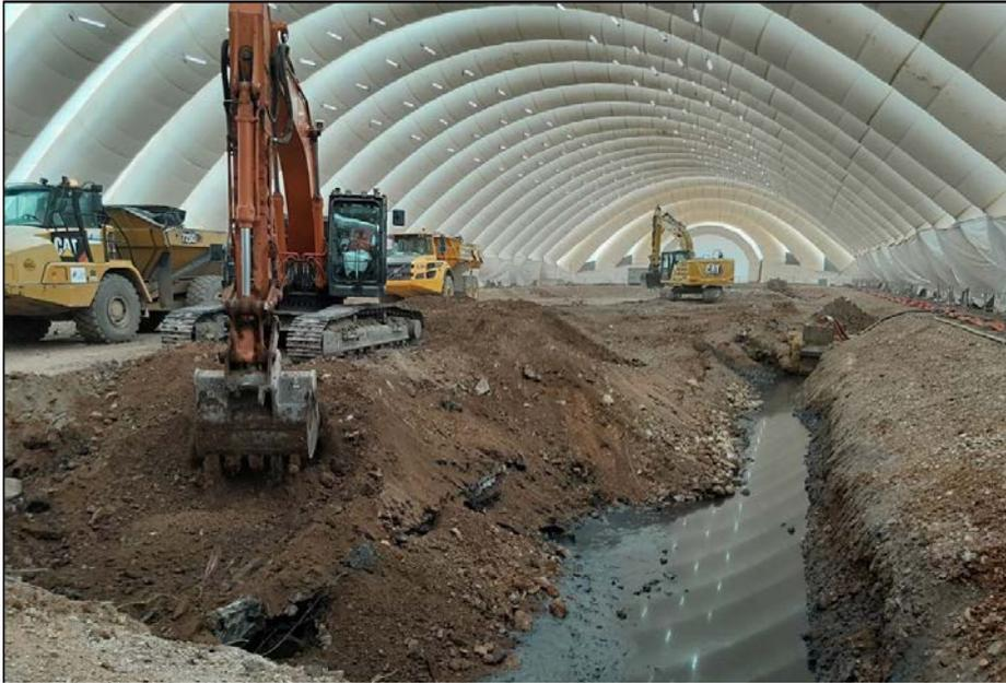
Photo 1 : Travaux d'excavation sous tente
