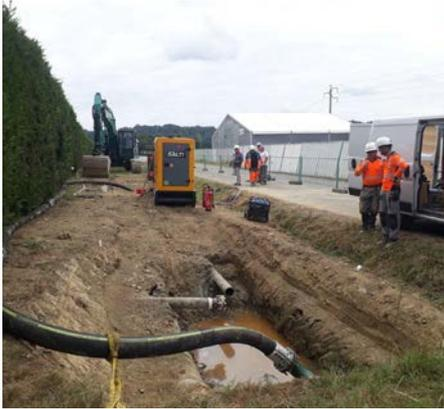
Figure 2 : Purge de la zone enherbée avec dévoiement des réseaux / Purge de la route
