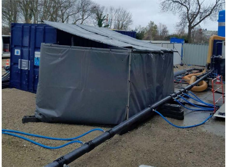
Figure 3 : Bâches acoustiques installées autour de la pompe de l'EMP
